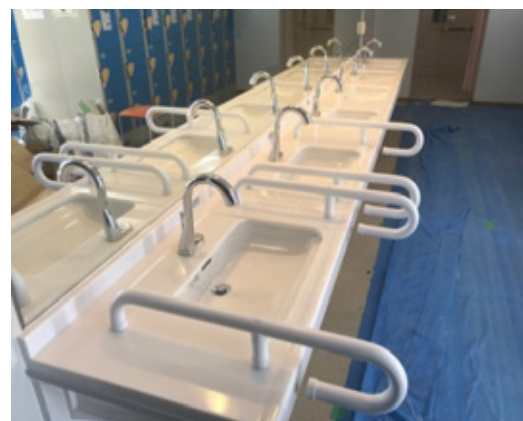
更衣室洗面台の改修状況
