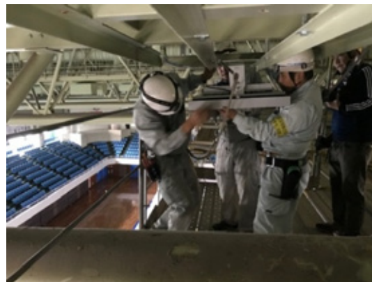
照明改修工事の状況
